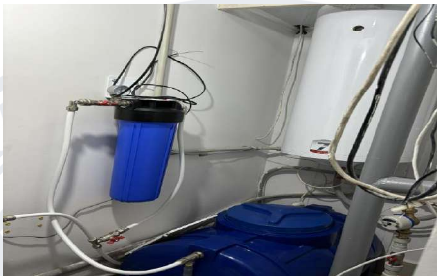
Рис 3.1. Кімната водопідготовки
