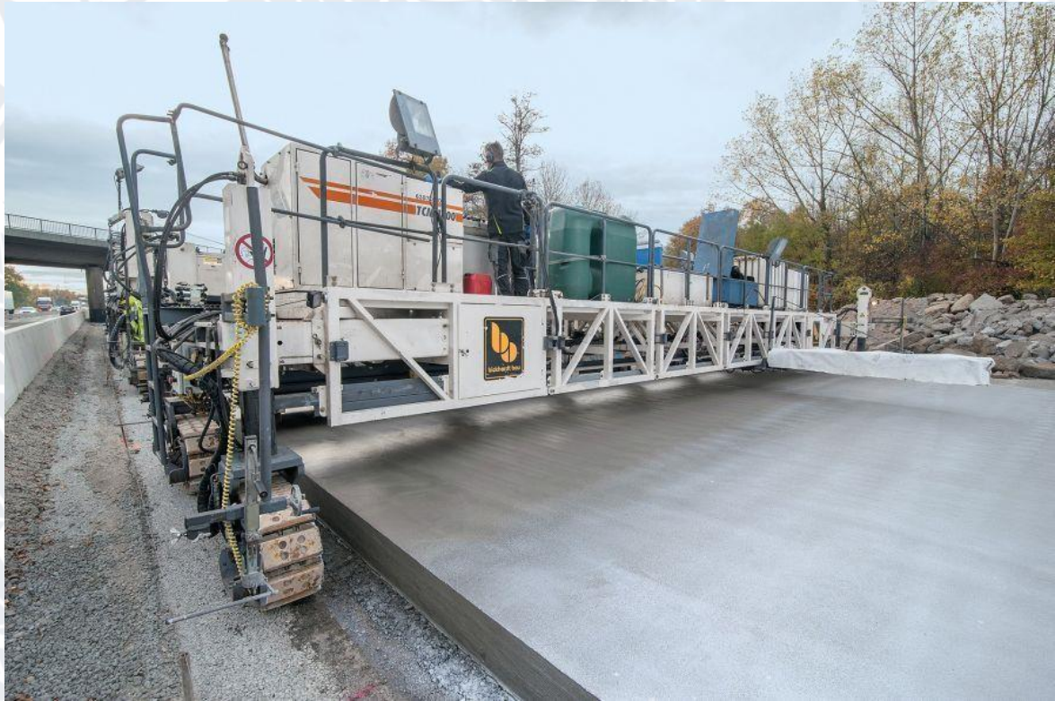
Рисунок 3.2 - Приклад укладання дорожнього покриття з використанням німецьких технологій
